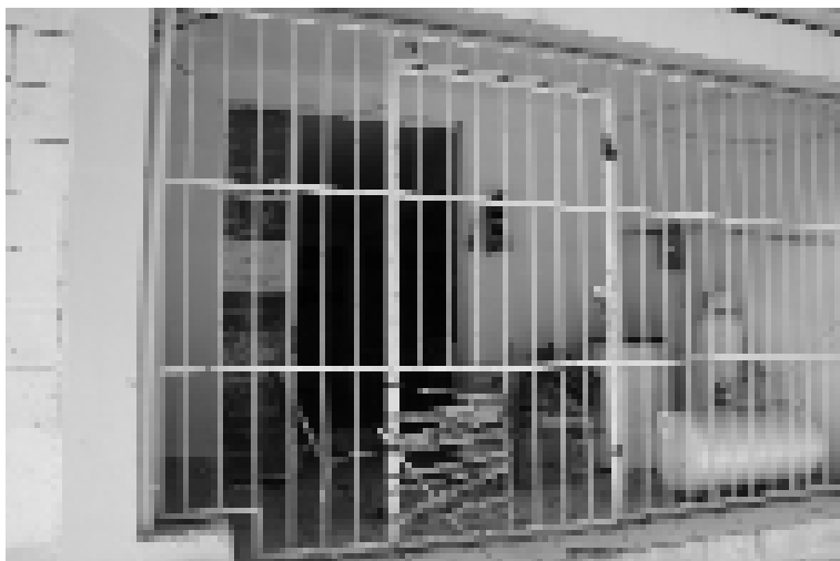
Imagen de la entrada al albergue Refugio de Amor, ubicado en la colonia Azteca.
